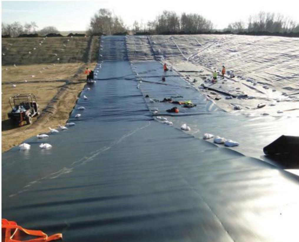
با توجه به اینکه ورقهای پلی اتیلن قابلیت جوشکاری دارند می‌توان پس از اتمام فرآیند قالب گیری قطعات مختلف ورقهای پلی اتیلن را با استفاده از جوشکاری هوایی داغ (Hot Air Welding) به یکدیگر متصل نمود و سطح پکارچهای با خاصیت غیر قابل نفوذ را ایجاد نمود.
